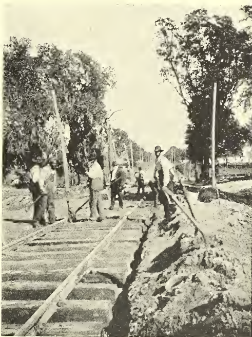
384. "L'HOMME À TOUT FAIRE" Negroes laying down a tramway in Florida
